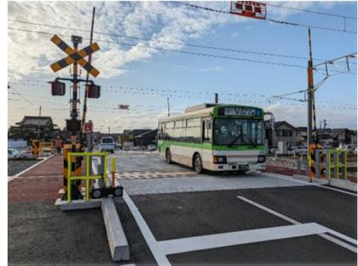
・新設した吉田踏切 踏切道を拡幅し歩行者用通路を新設
