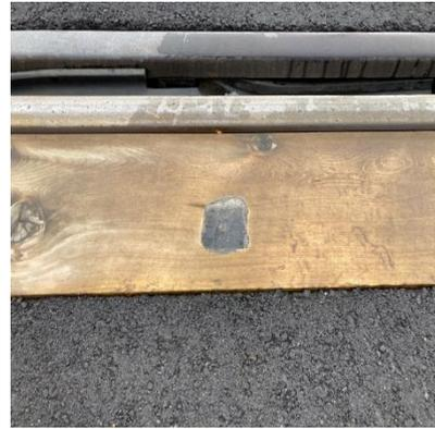
・釘を新たに打ち込み、釘の頭をレール面より低くなるように削り、平面化した
