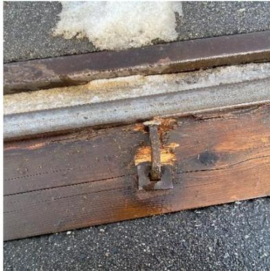
・浮いた釘の頭が折れ曲がり、レールに接近している
