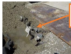
<改善事例> (地盤改良工事)
