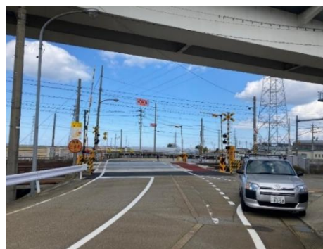
・踏切道を拡幅
