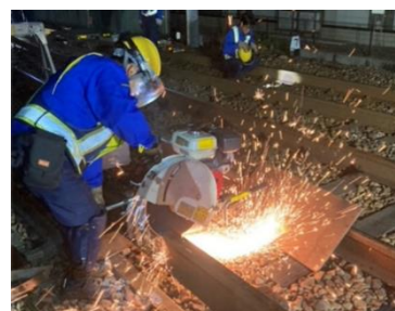
・ レール交換訓練
