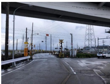
・呉羽～富山駅間 馬面踏切 踏切設備の整備
