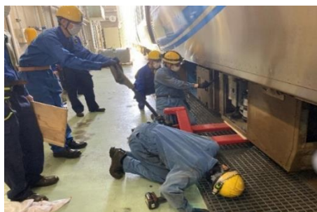
・521系車両 コンプレッサー交換
