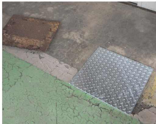
・新品の蓋に交換を実施した
