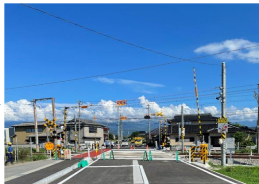
・踏切道拡幅後
