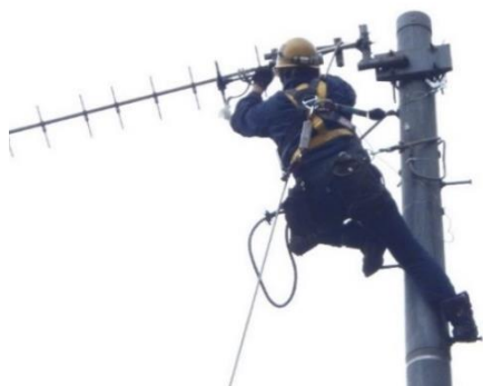
・アンテナ取り替えの様子
