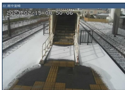
・遠赤外線で照らされた範囲が除雪されている
