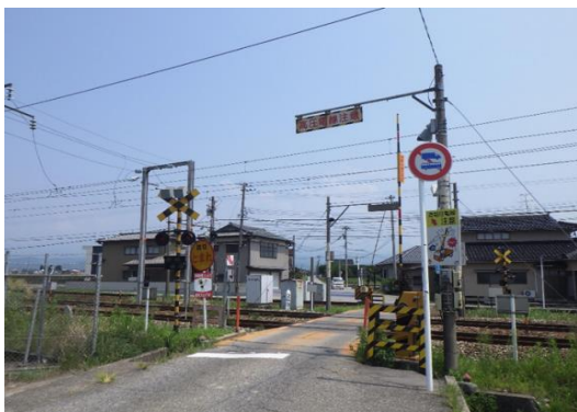
・踏切道拡幅前
