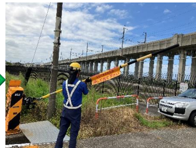
・内側から遮断かんを押すと斜め上に押しあがり、踏切の外へ出ることが出来る
