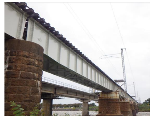
・防さび塗装を実施
