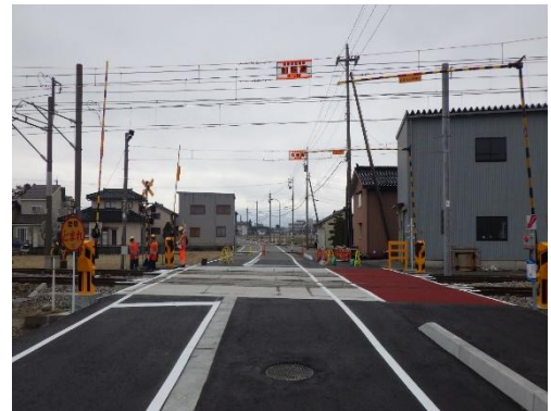
・整備後の新村踏切 踏切道を拡幅し歩行者用通路を新設
