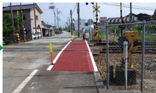
・カラー舗装後
