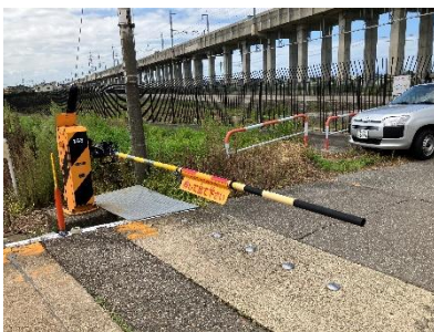
・内側から遮断かんを押すと斜め上に押しあがり、踏切の外へ出ることが出来る
