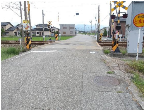
・生地～西入善駅間 新村踏切 踏切設備の整備
