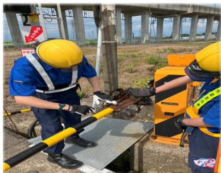
・呉羽～富山駅間 第2小竹踏切遮断桿取り替え
