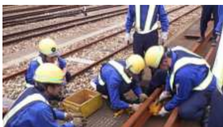
【施設係員によるレール折損措置訓練】
