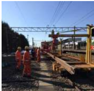
【レール交換（泊駅）】
