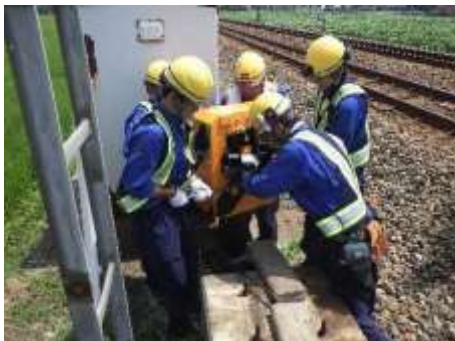
【踏切遮断機交換風景（木舟踏切）】
