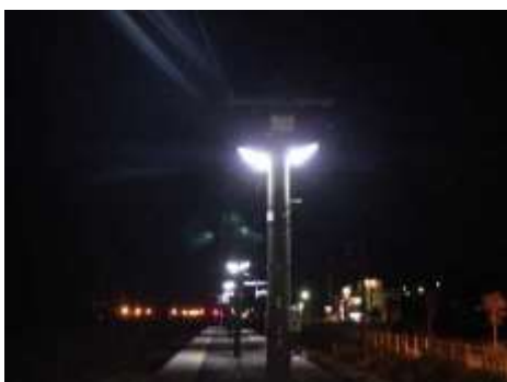
【ホーム照明のLED化（石動駅）】
