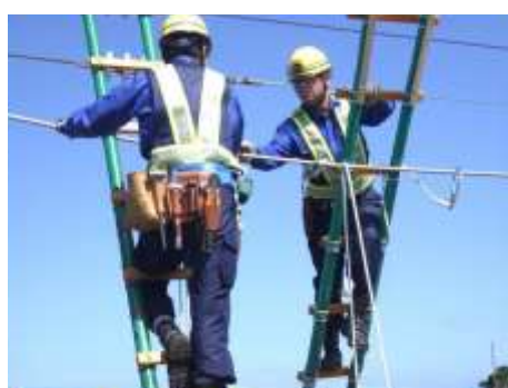
【電気係員による架線張替訓練】
