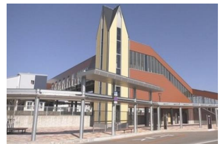
石動駅新駅舎・南北自由通路
